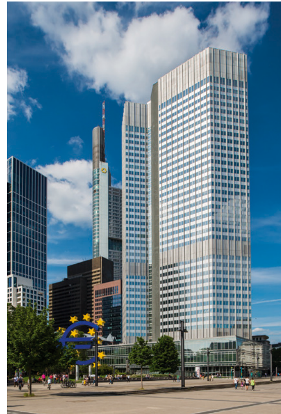
Für die Furbon Life, führender Versicherer in der Republik China, wurde der Euro-Tower erworben – eines der markantesten Wahrzeichen im Frankfurter Bankenviertel.
